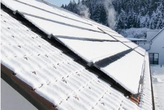
SNOWtecc ist eine speziell entwickelte Schiene, die als Teil der Unterkonstruktion von Photovoltaikanlagen dient. Sie verhindert das unkontrollierte Abrutschen von Schnee und bietet somit einen effektiven Lawinenschutz.
